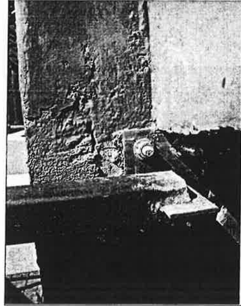
Fotografía N° 25: Pletinas metálicas de pilastras, de la acera aterrazada del sector reloj, sin la pintura indicada.
